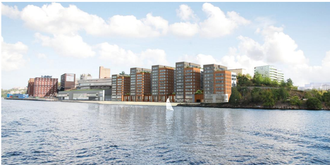
Norrhusen, nordvästra kajen, vy mot sydost
