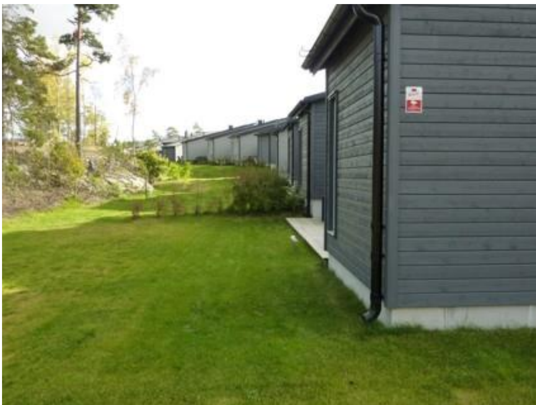
Figur 9. Stuprör med utkastare mot grönytan. Vattnet kan infiltrera i grönytan och vid större flöden avleds vattnet ytledes mot ett svackdike (t.v. i bild). Foto: WRS
