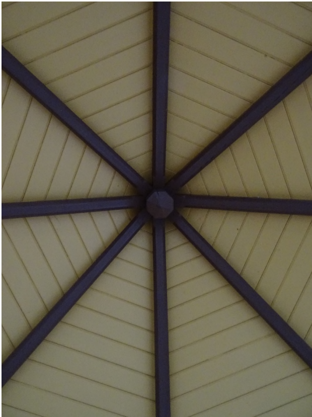
Taket inifrån sett.
