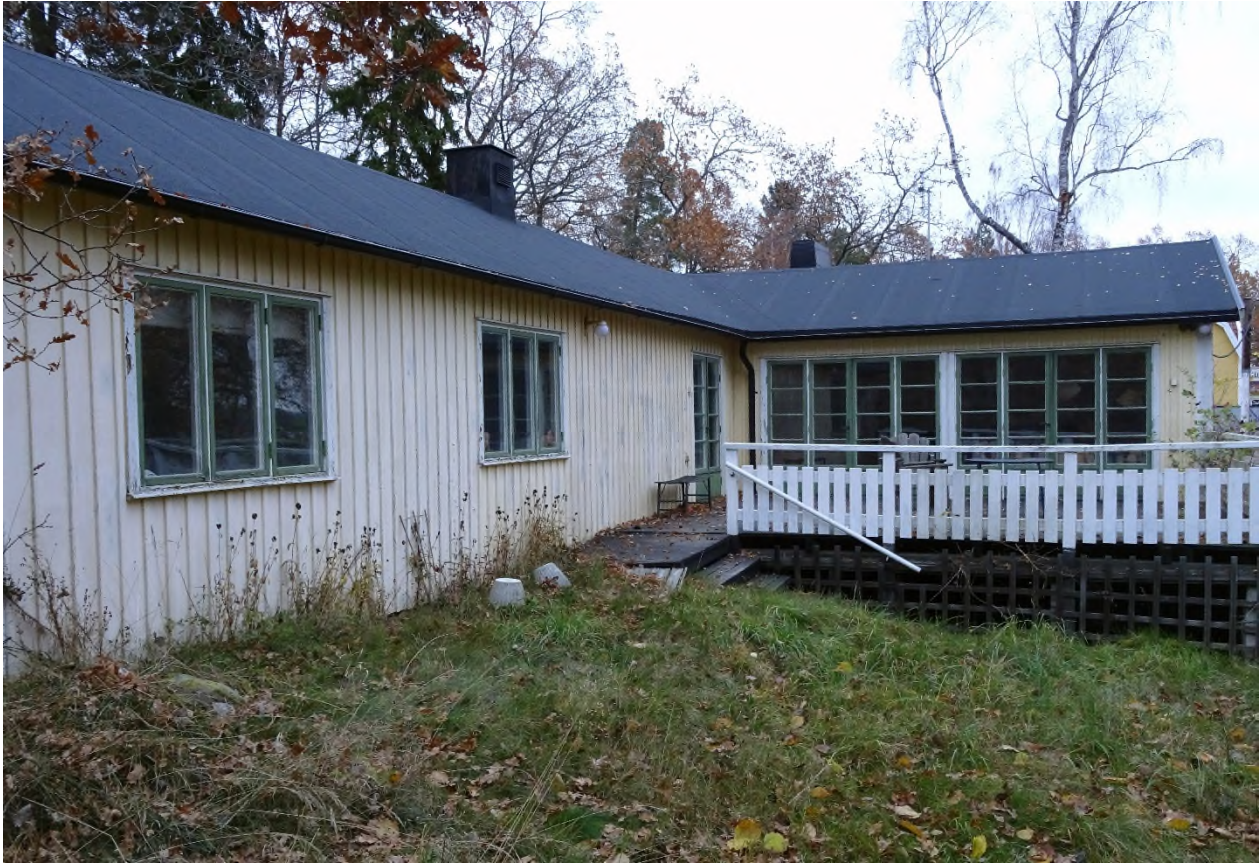
Bo 1:56, fasaderna mot söder och väster.
