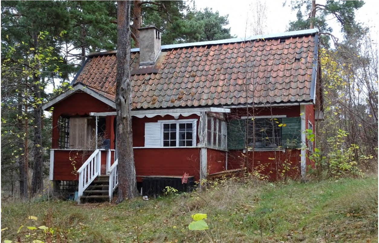
Bo 1:81, sportstugan sedd från Lotsvägen.
