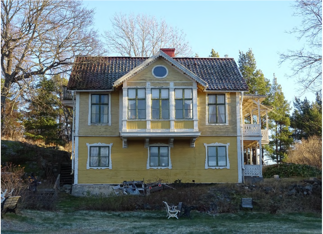
Backeböl 1:820, Vita villan. Västra fasaden mot sjön.
