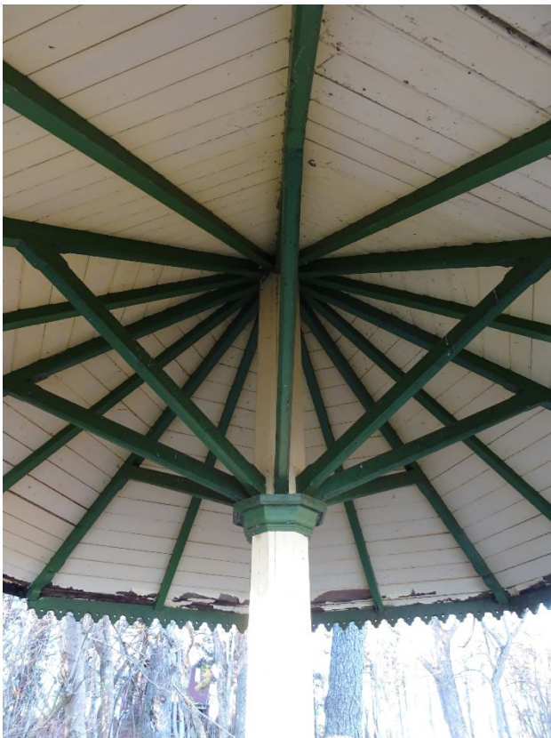
Takkonstruktionen är utformad som en parasoll.
