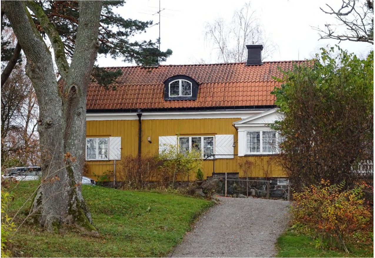
Bo 1:30, Granngården, sedd från Baggensvägen.
