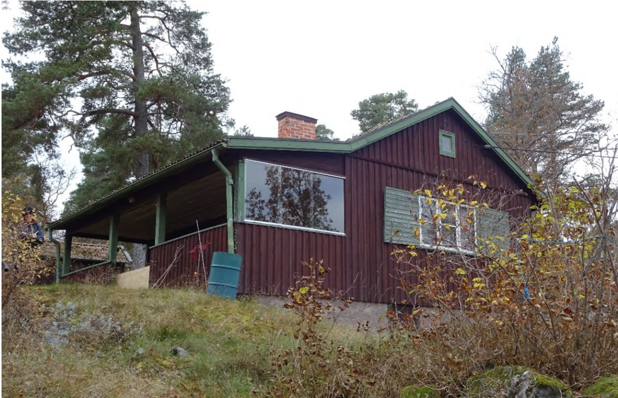
Bo 1:67, södra och östra fasader. Uthuset skymtar till bakom huvudbyggnaden.
