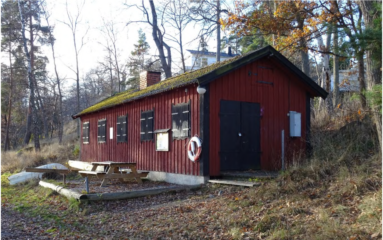
Klubbhuset sett från norr.
