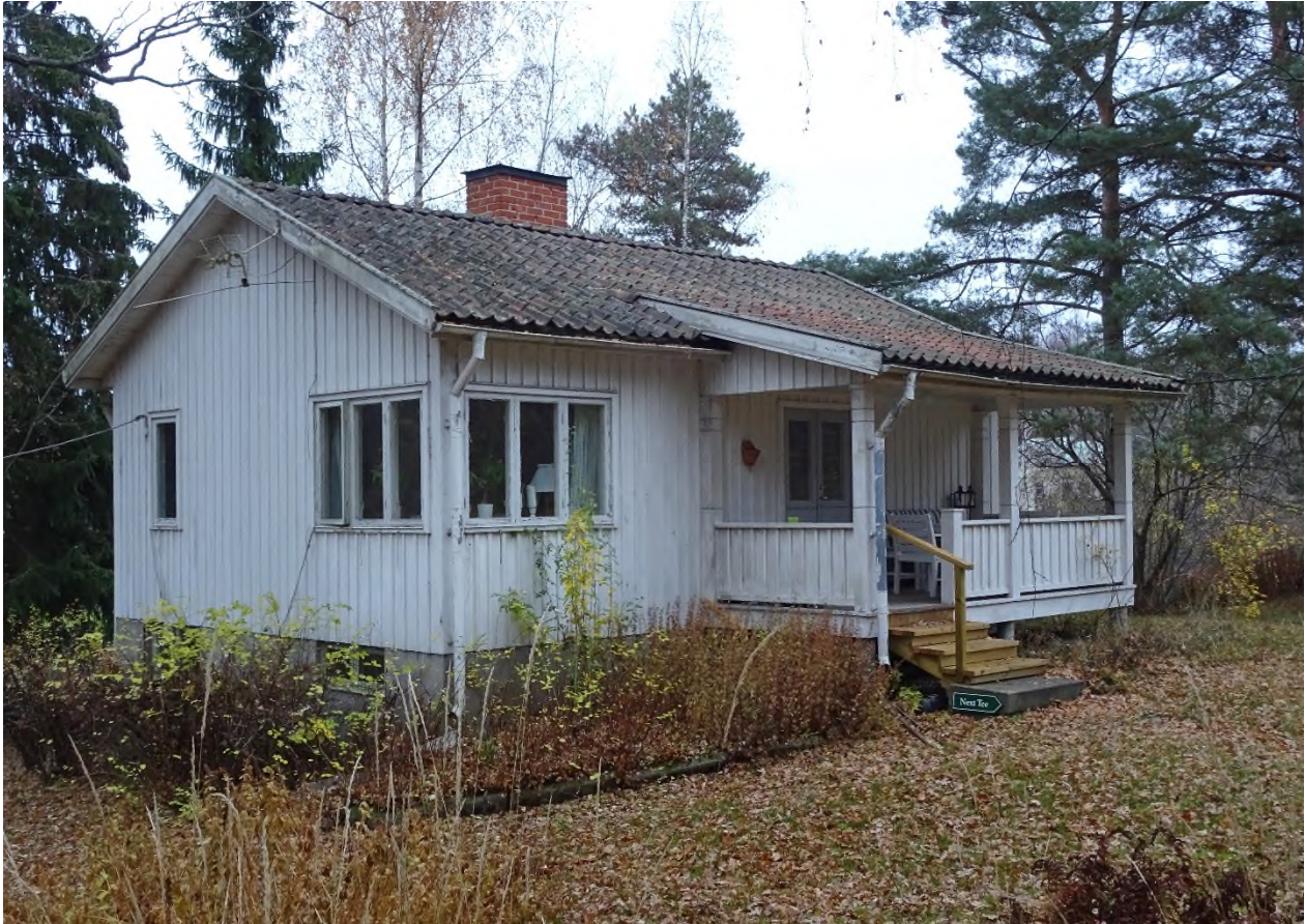
Backeböl 1:669, sportstugans södra och östra fasader.
