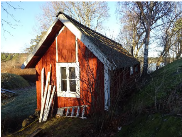
Fd ladugården. Södra gaveln och baksidan mot berget i öster.
