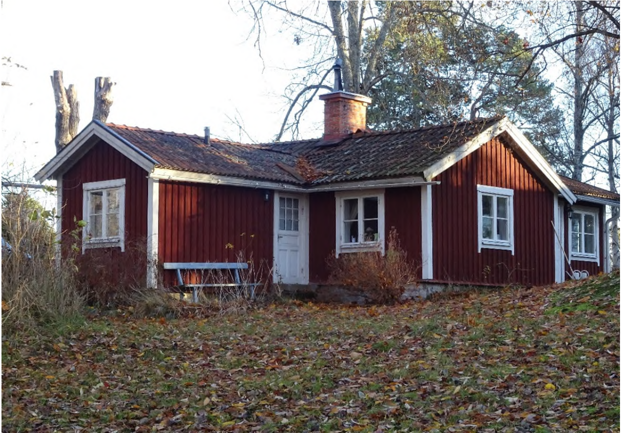
Backeböl 1:767, fasaden mot nordost.
