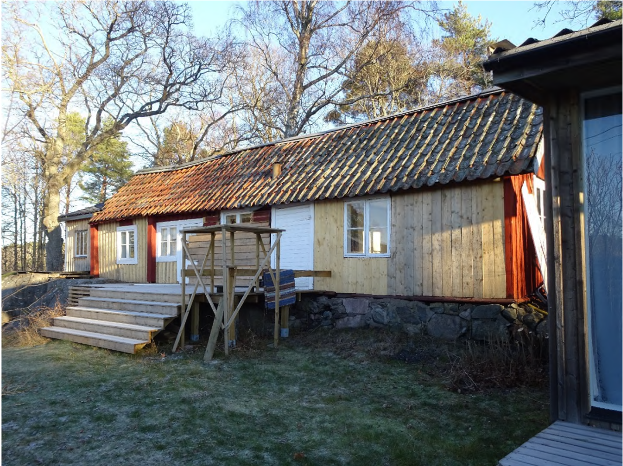
Backeböl 1:819, fd ladugården. Entrésidan mot väster.
