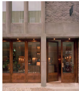
Entrémotiv med samspel av betong, tegel och trä.
