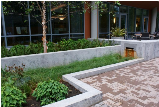
Figur 5. Exempel på utkastare och rännor kopplade till växtbädd.
