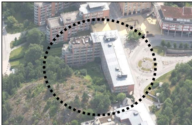
Befintlig kontorsbyggnad som föreslås ersättas
