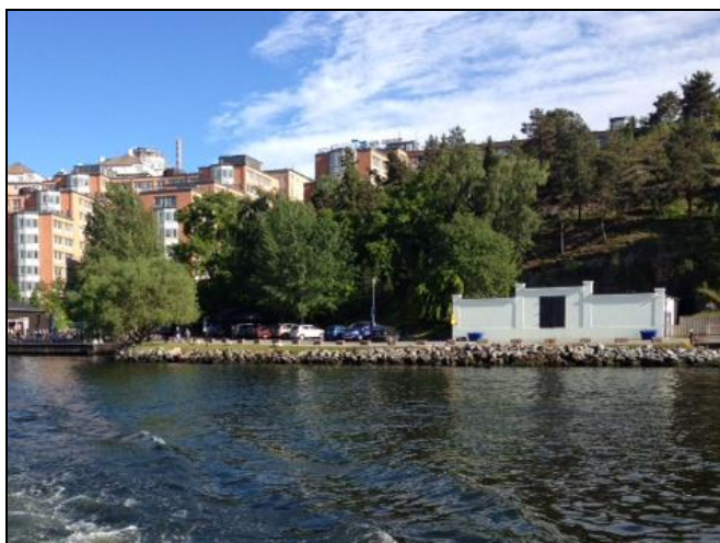
Den före detta oljekällaren med sin karaktäristiska fasad.
