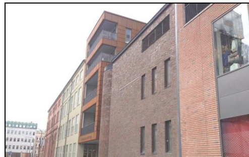
Avvikande volym av cortenplåt i Sundbyberg.
