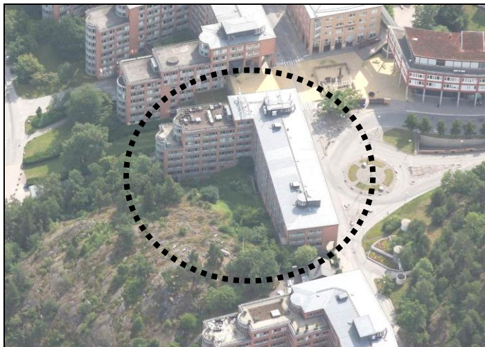
Befintlig kontorsbyggnad som föreslås ersättas
