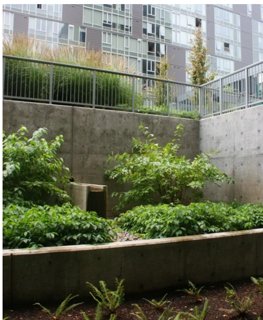
Avvattning av terrasserade innergårdar med hjälp av planteringar, rännor och överfall.
