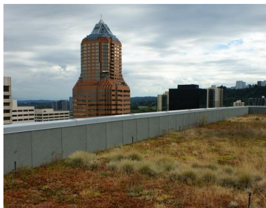
Konventionellt grönt tak med sedumväxter.
