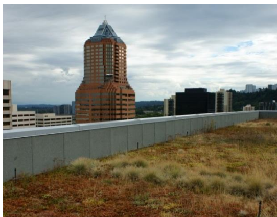
Konventionellt grönt tak med sedumväxter.
