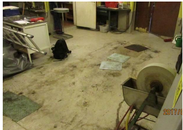
Bild 4. Verkstadens betonggolvet med synliga föroreningar
