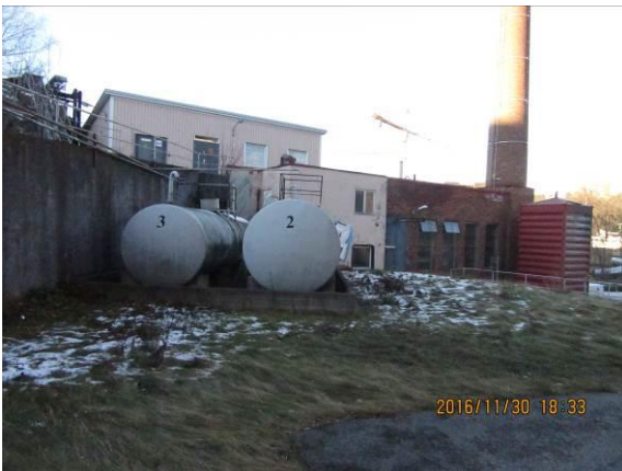
Bild 3. Panncentral sett från öst.
