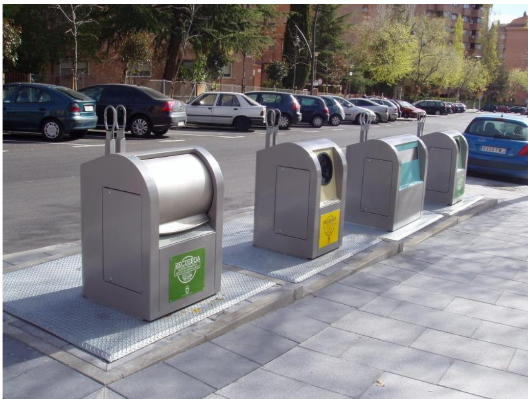
Figur 11. Terrassering vid underjordsbehållare. (Källa: Anna Grill, Plastic Omnium.)
