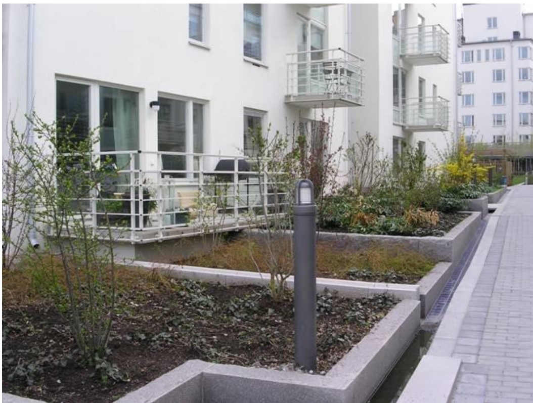
Figur 15. Stupsröskastare (till vänster) på ett flerfamiljshus med avledning till växtbädd.
