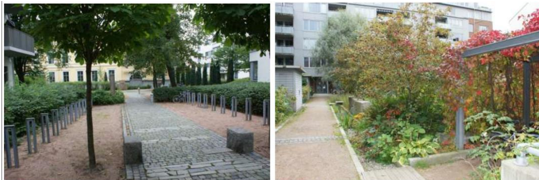
Figur 17. Permeabel beläggning på innergårdsområde.
