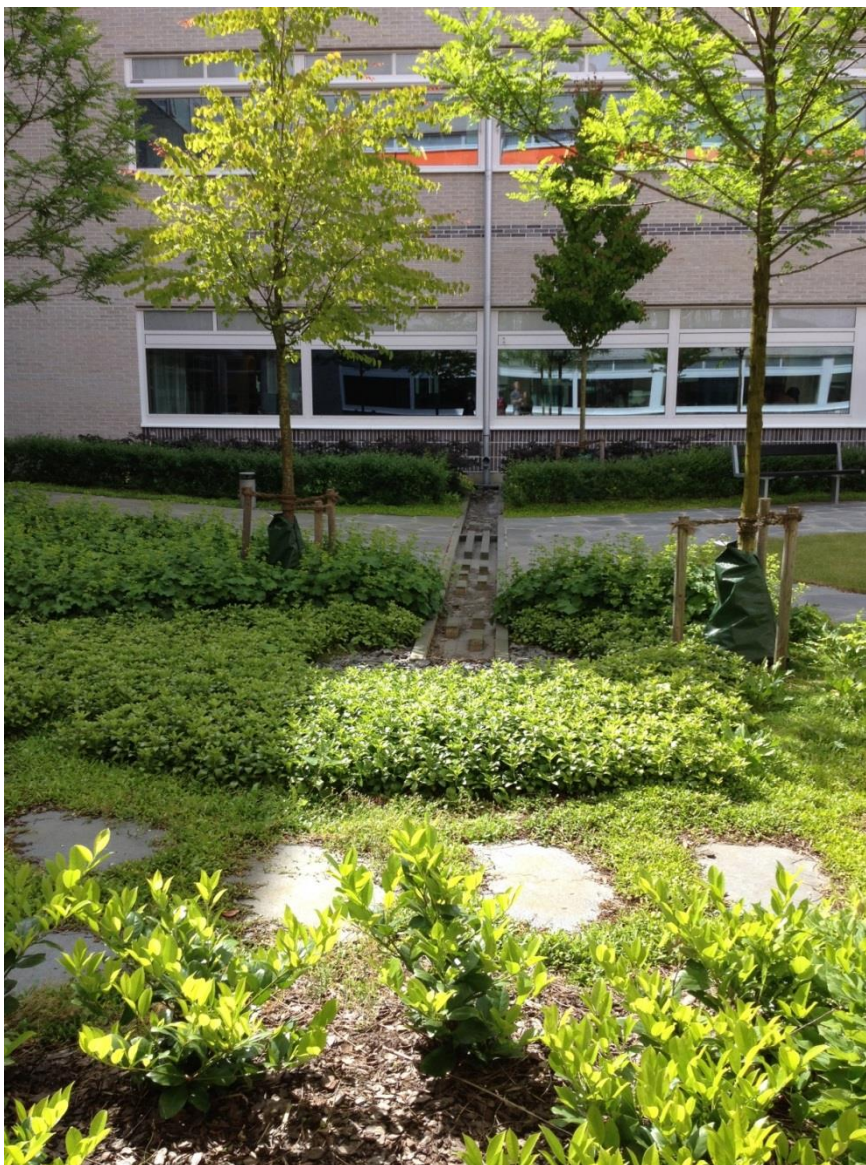
Figur 16. Stuprörsutkastare längs husvägg med avledning via rännal mot dagvattenhanteringsområde.
