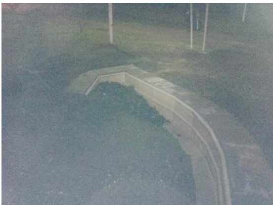
Figur 13. Barriär vid Spångavägen. Anläggningen är byggd med prefabricerade block från ACO system för amfibietunnlar. Här visas änden av barriären där en "krok" anlagts för att öka chansen att groddjuren går mot passagen istället för åt fel håll. Foto: Anna Koffman.
