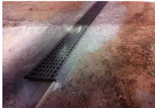
Figur 14. Färist från ACO system för amfibietunnlar. Färistar behövs vid anslutande gator, GC-vägar etc. Foto: Anna Koffman.
