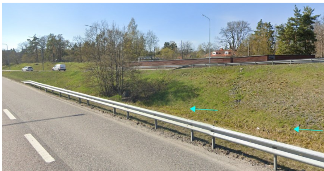
Figur 9: Befintlig nedstigningsbrunn i lågpunkt (Google maps 2023-08-25).
