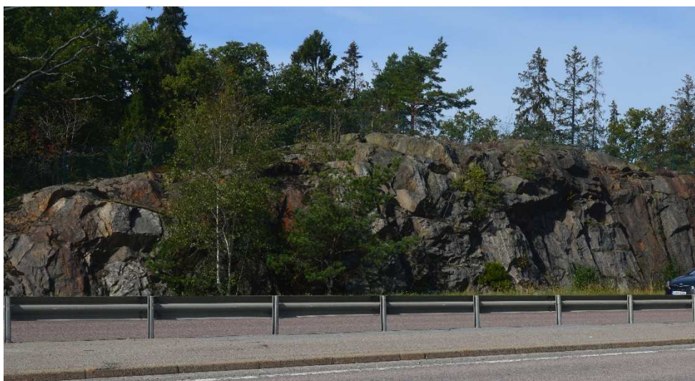
Figur 6-5. Bild på skärningen längs Ormingeledens södergående led. Betydligt större påverkan av rostbildning.
