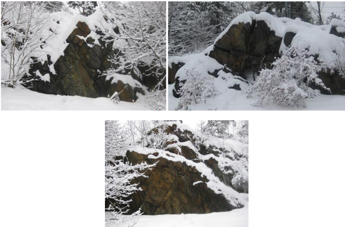
Figur 3. Sydlig bergskärning längs Värmdöleden. Berget är ställvis blockuppsprucket i tre till fyra sprickriktningar.
