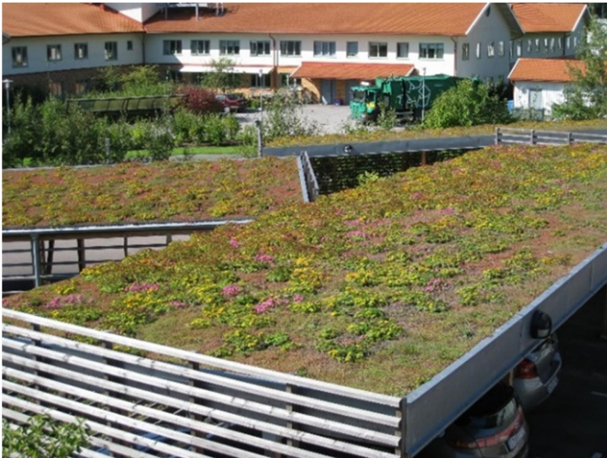
Figur 7. Exempel på sedumtak över garage. Bildkälla: VegTech AB.
