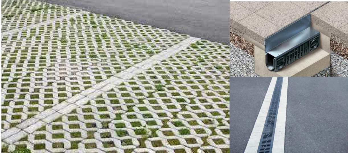
Figur 9. Exempel på genomsläpplig P-yta. Till höger – exempel på rännor som hanterar ytavrinning.
