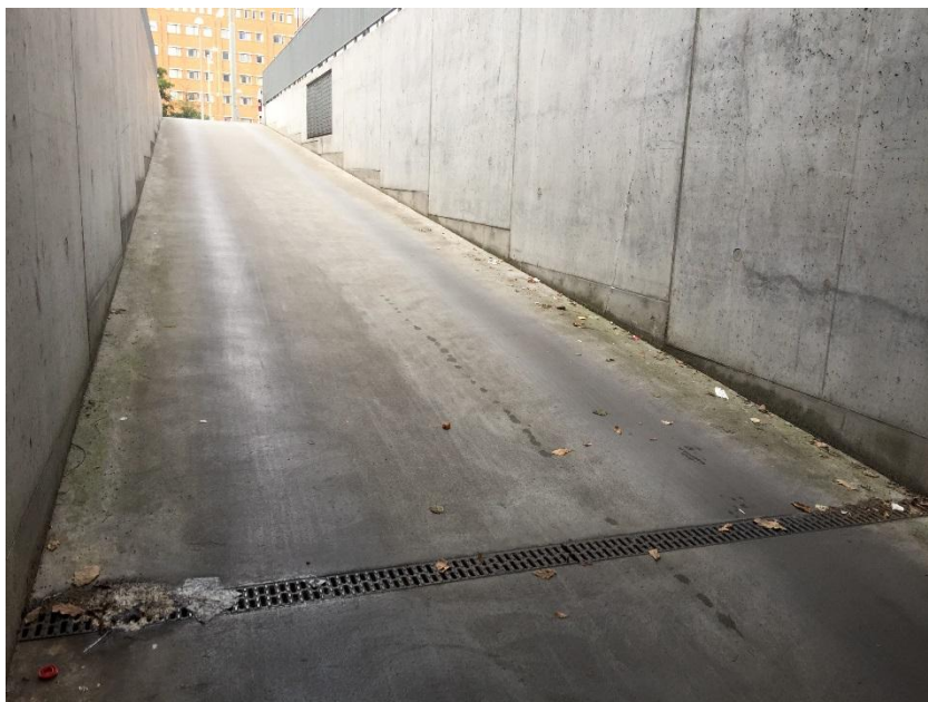
Figur 10. Exempel på dagvattenränna vid garageinfart.
