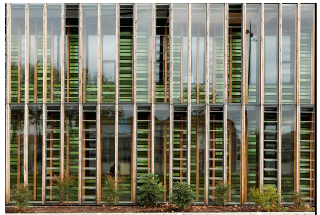
Referensbild: kulören på fasaden bakom skymtar igenom det yttre fasadlivet.
