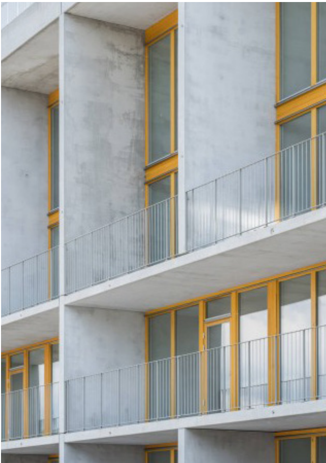
Referensbild: Fönsterkarmar utförda i gul accentkulör som bryter mot fasadens material (Källa: JOLIARK).
