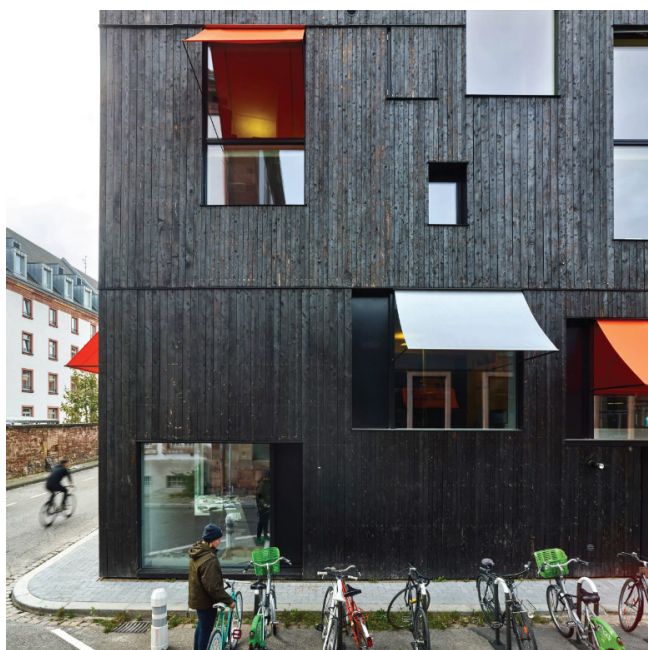
Referensbild: byggnadens möte med gata (Källa: Dominique Coulon & Associés).
