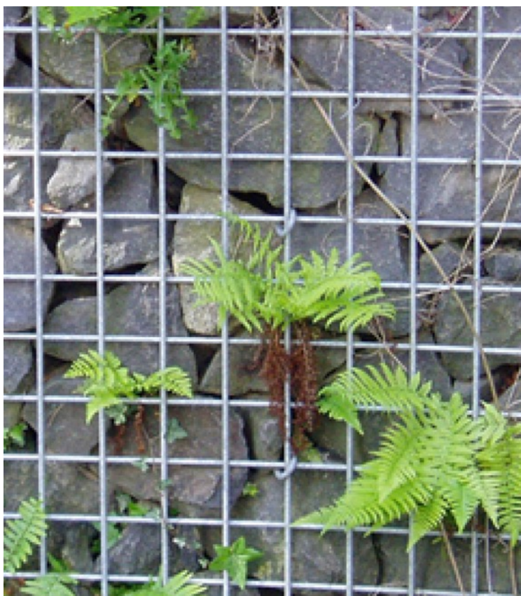
Figur 6: En grön gabionmur med ormbunkar, skapar ett mer levande intryck av stenmuren. Bild från Byggros "Vectorwall grön".
