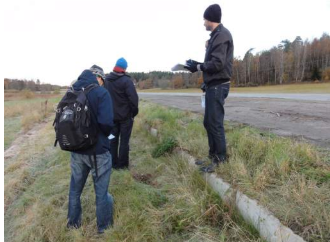
Figur 12. Ca 10 år gammal barriär vid Skårby. Här har skötseln blivit eftersatt och den uppväxta vegetationen kan medföra att groddjur klättrar upp. Foto: Anna Koffman.
