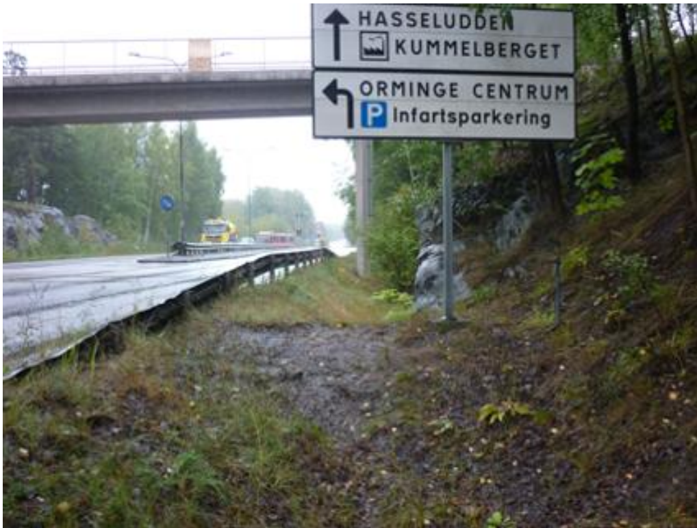
Figur 3. Mensättravägen fotograferad mot norr från söder om GC-bron. Vägdikena sluttar söderut från i höjd med gc-bron. Foto: WRS.
