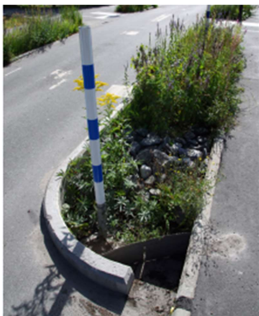
Figur 20. Exempel på hur ett avbrott i kantstenen kring en växtbädd kan användas för att skapa ett inlopp för dagvattnet. Bild av WRS hämtad från Stockholm Vatten och Avfall (SVOA).
