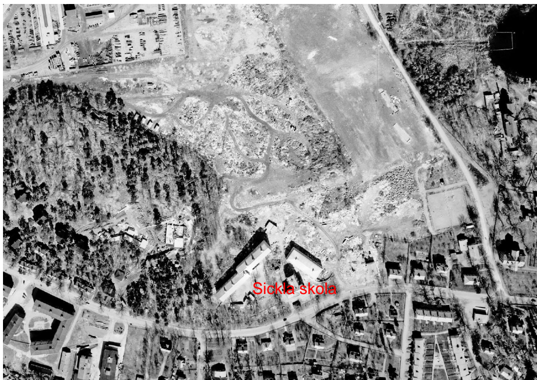
Figur 4. Flygfotografi över Planiaområdet år 1955, visande bland annat deponin. Befintliga byggnader för Sickla skola, som även syns i figur 1, är markerade.
