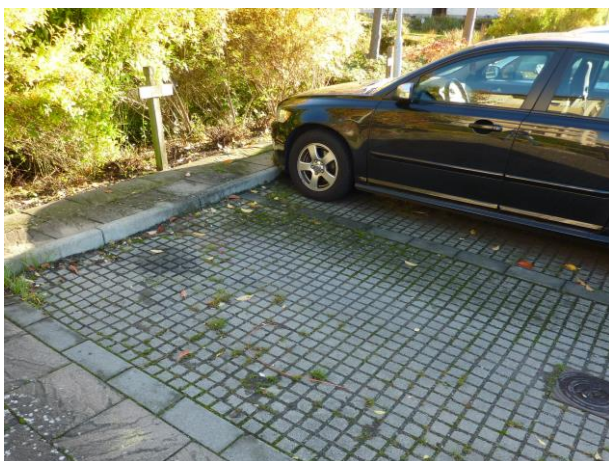
Figur 19. Exempel på utformning av parkeringsplats med betongsten med glesa fogar. Foto: WRS.
