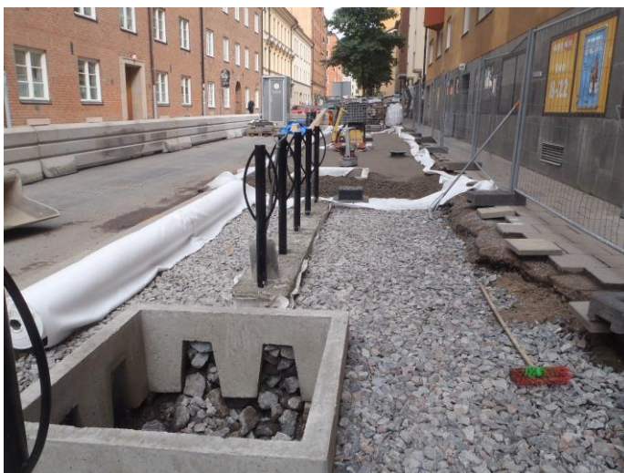
Figur 17. Exempel på etablering av skelettjord i befintlig miljö i Stockholm. Foto Björn Embrén Trafikkontoret.
