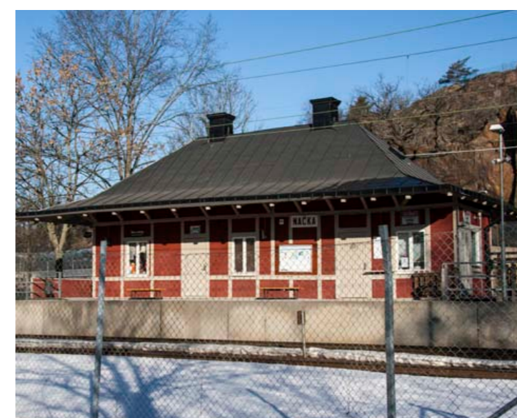
Stationsbyggnaden vid Nacka station
