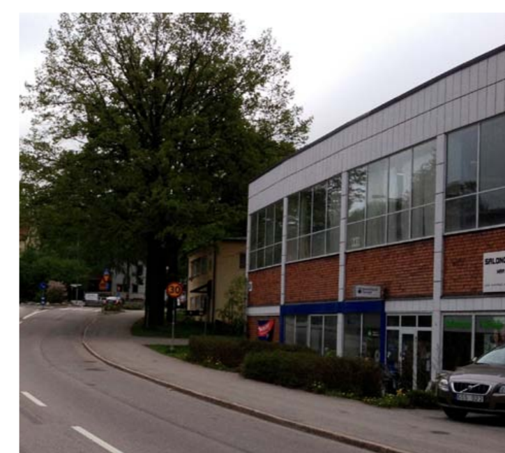
F.d. industribyggnad invid Planiaavägen
