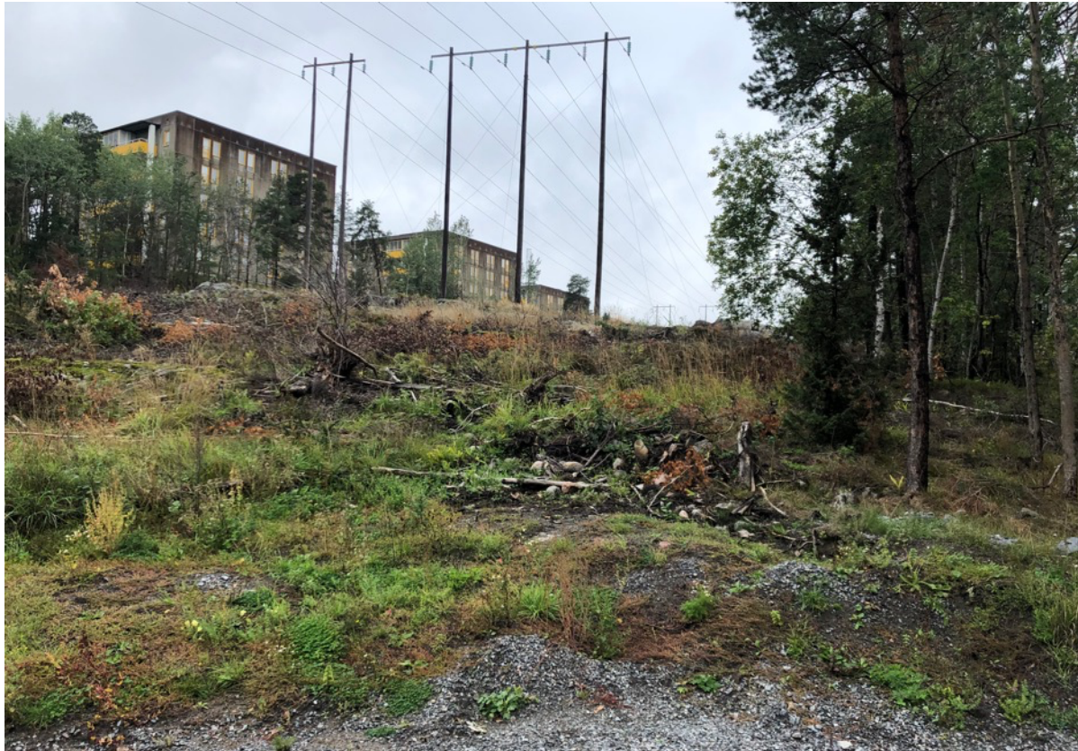
Kraftledningsstråket i Orminge i planområdet Pylonen september 2019.
