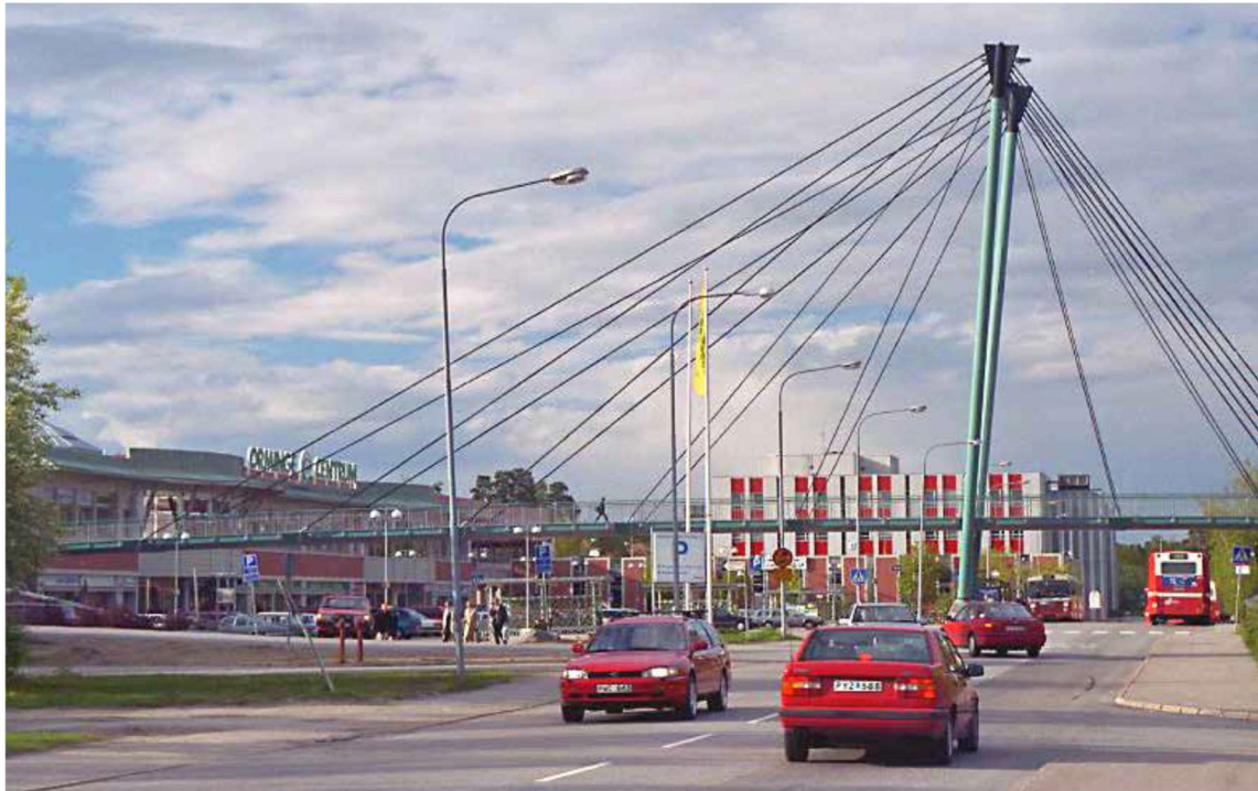
Orminge centrum, Kanholmsvägen. Centrumbuset till vänster i bilden och Ormingehus bakom snedkabelbron.
