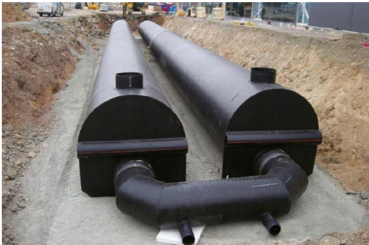
Figur 6-6 Underjordiskt rörmagasin
