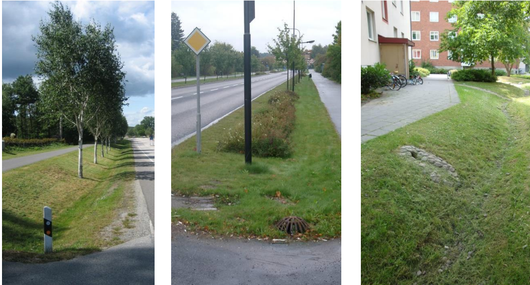
Figur 14. Exempel på svackdiken.
