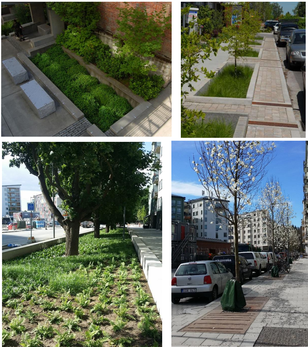
Figur 12. Exempel på utformning av växtbäddar i gaturum och på allmän platsmark/kvartersmark. Bilderna visar exempel på en växtbädd i bostadsmiljön (uppe t.v.), en öppen lösning med separata växtbäddar (uppe t.h.), en öppen kontinuerlig växtbädd (nere t.v.), samt en gallertäckt lösning med separata växtbäddar (nere t.h.).
