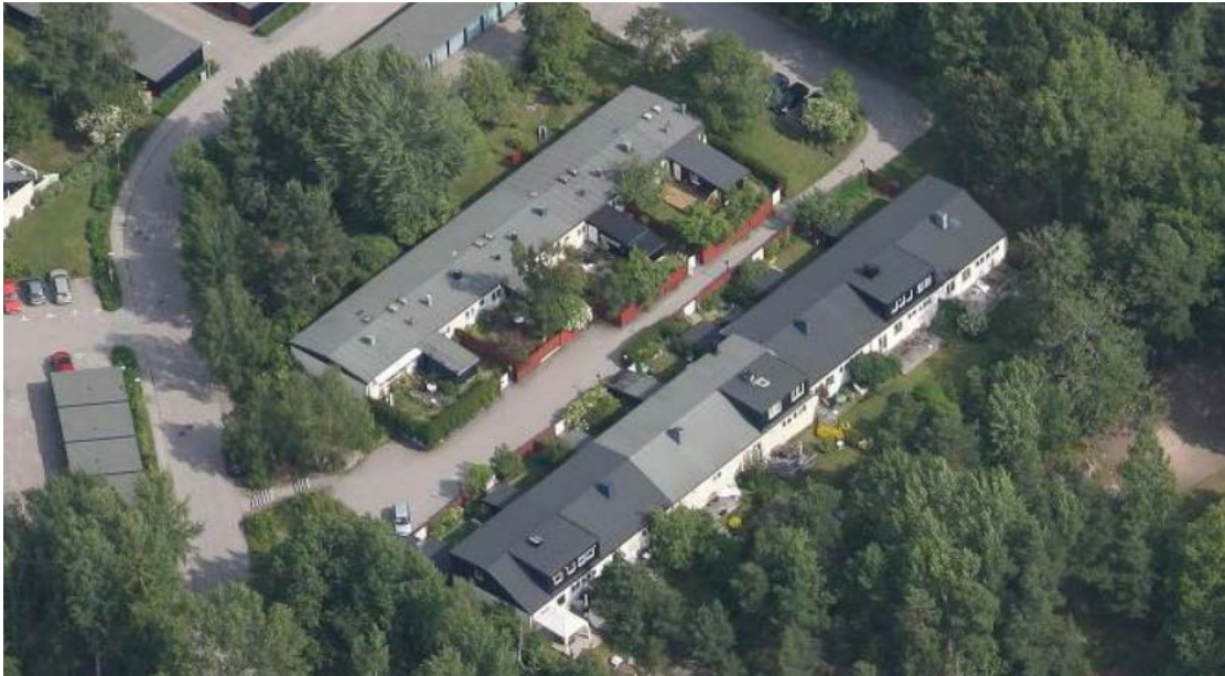
Befintlig bebyggelse med 1 våning respektive 1 våning med inredd vind där vissa fastigheter byggt takkupor.
