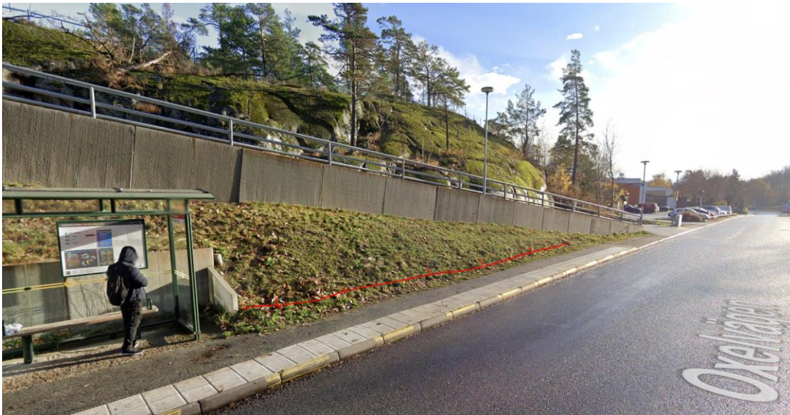
Figur 11 Ny stödmur Källa:Google
