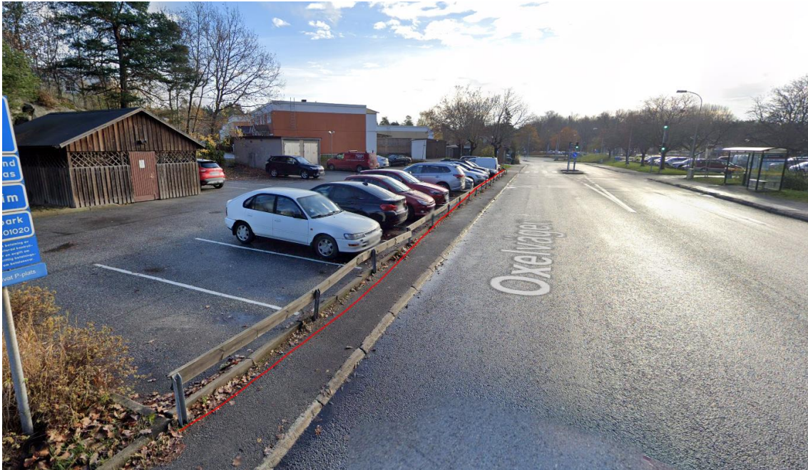
Figur 10 Ny stödmur Källa: Google
