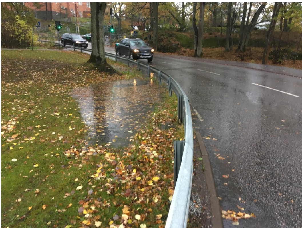
Figur 7. Befintlig dagvattenbrunn i Byvägen hade begränsad bortledningskapacitet vid platsbesök 30/10-18.
