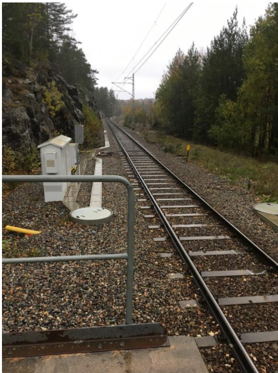
Figur 15. Vy mot norr från befintlig plattform, mot området för de planerade plattformarna. Berg i dagen på södra sidan och makadan/ballast och gränsslänt på den norra sidan.
