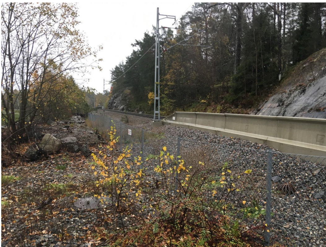
Figur 16. Vy från norr, där norra delen av de nya plattformarna ska placeras. Befintlig kupolsilsbrunn och spolbrunn.
