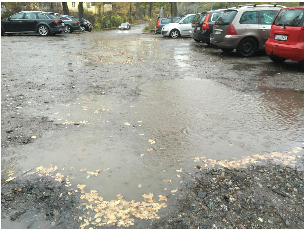
Figur 11. Befintlig grusparkering bedöms ha låg infiltrationskapacitet vid kraftig nederbörd såsom på bilden så finns idag inte tillräcklig infiltrationskapacitet.
