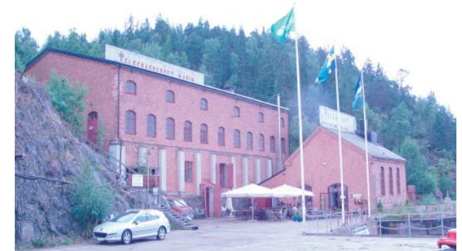
Befintliga tegelhus på kajen
