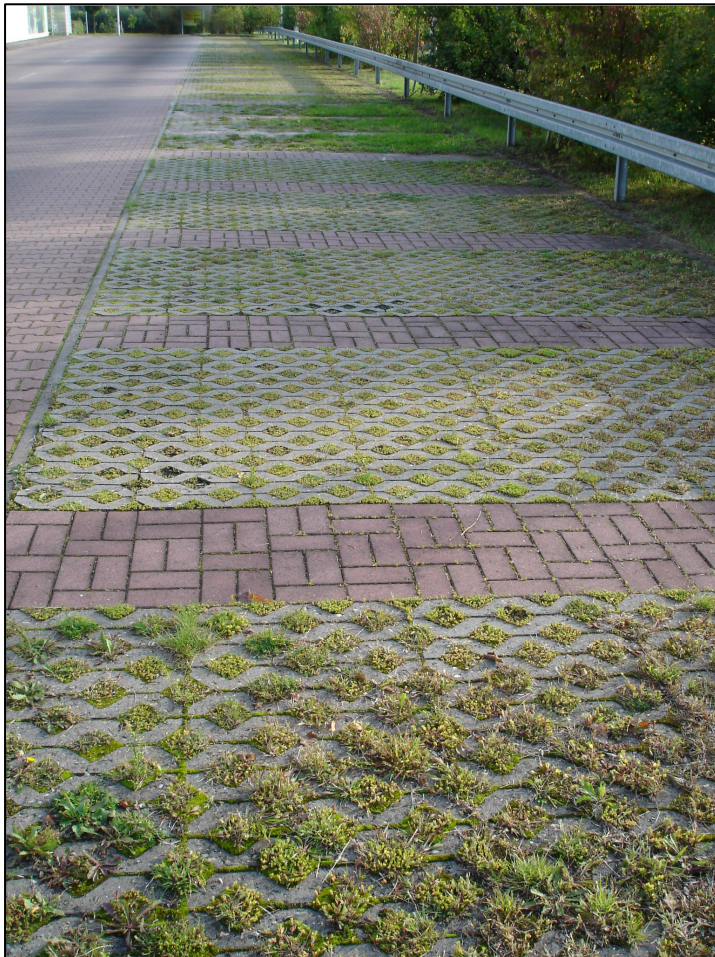
Figur 14. Exempel på genomsläpplig beläggning i form av gräsarmering med betonghålsten. Foto WRS.
