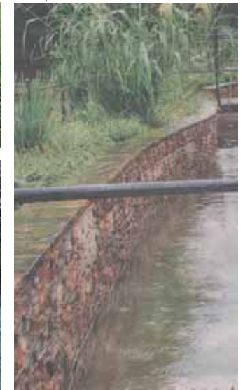
Tegel från bruket kan användas som stödmur mot vattenytan eller i krossad form på botten av dammarna
