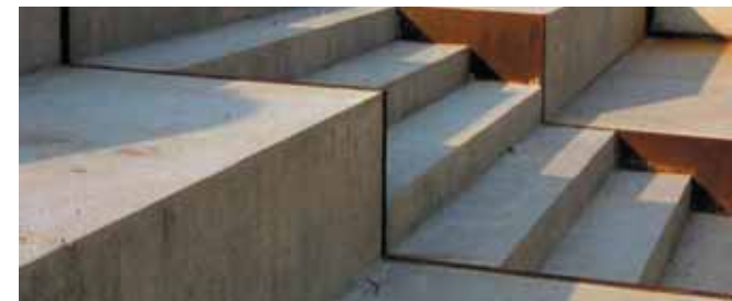
Platsgjuten betongtrappa med kantstöd av corténplåt
