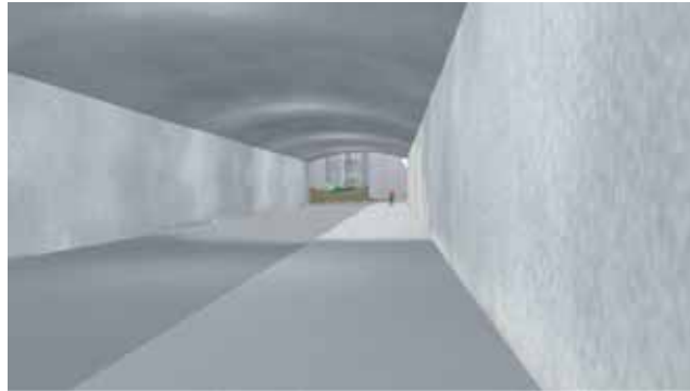
2, mitt i tunneln.
