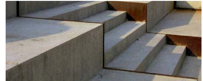
Platsgjuten betongtrappa med kantstöd av corténplåt
