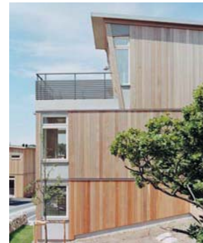
Utsiktsgatans villabebyggelse terraseras mot solen och vattnet. Snäckeberget (White Göteborg)
