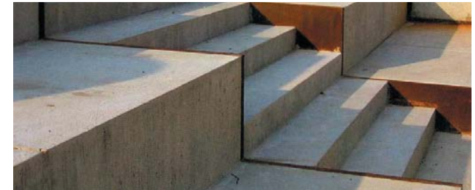
Platsgjuten betongtrappa med kantstöd av corténplåt
