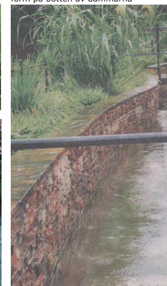
Tegel från bruket kan användas som stödmur mot vattenytan eller i krossad form på botten av dammarna
