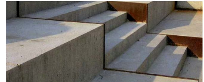
Platsgjuten betongtrappa med kantstöd av corténplåt
