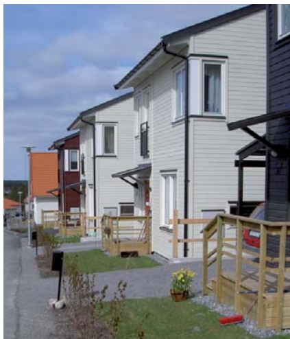
Kvartersgata med småhus. Hedvigslund Älta, (Arken Arkitekter)
