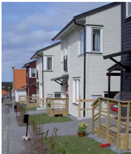
Kvartersgata med småhus. Hedvigslund Älta, (Arken Arkitekter)
