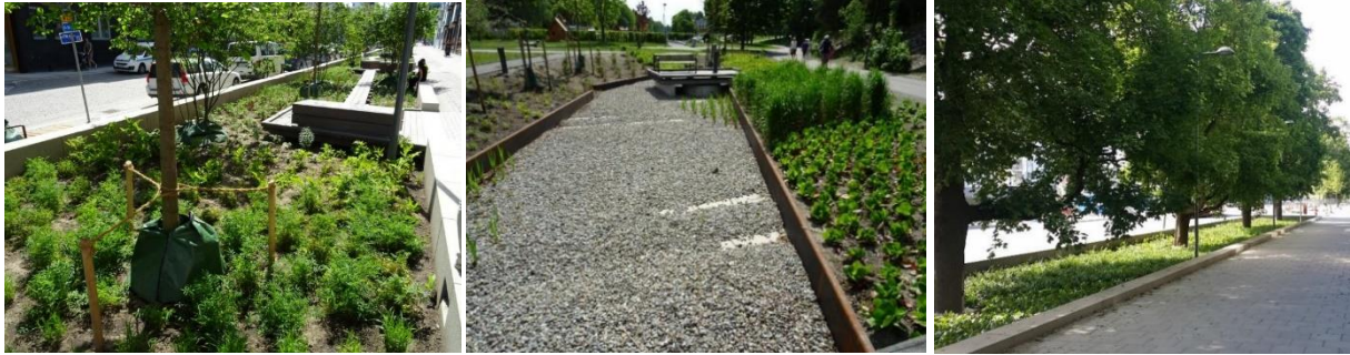
Figur 11. Exempel på öppna växtbäddar inhämtade ur Nacka kommuns anvisningar för dagvattenhantering (Nacka Kommun, 2018). Växtbäddar kan anläggas med eller utan träd beroende på hur djup anläggningen kan vara. Buskväxter och perenner kräver inte lika djupa växtbäddar. Grusyto kan fungera som öppna makadammagasin utan vegetation.
