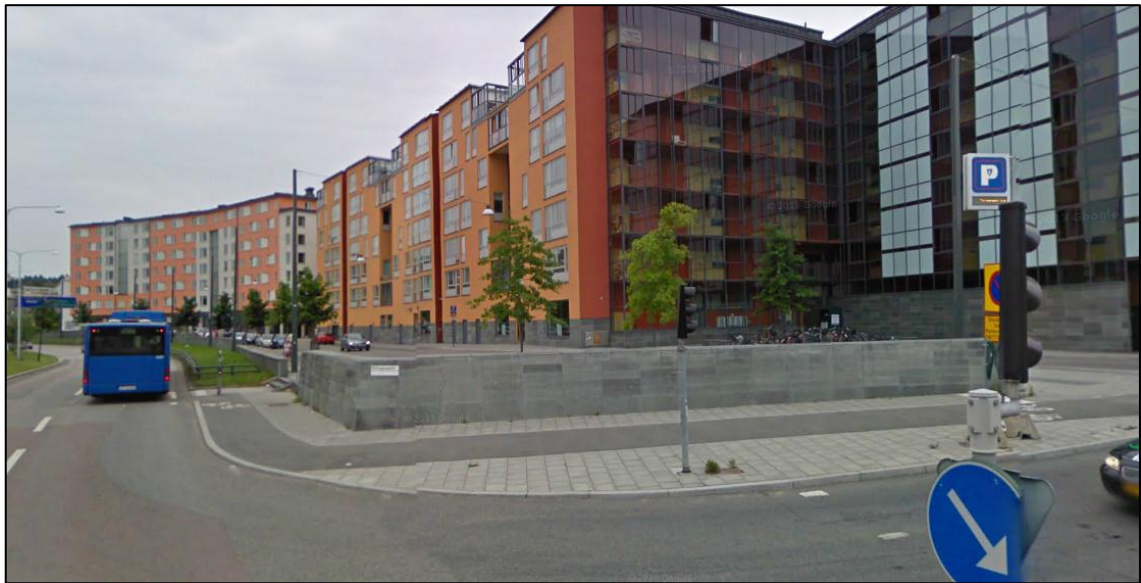
Figur 15. Vy mot Kv Forsen och den mur som uppförts som skydd mot avåkande fordon och pölutbredning mot bebyggelsen.
