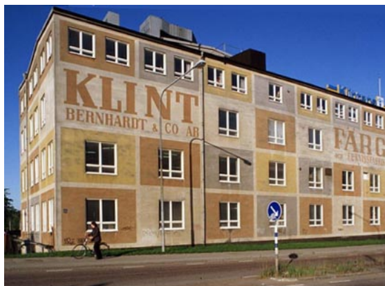
Färgfabriken "Klintens" 1950-talsfasad mot Värmdövägen
