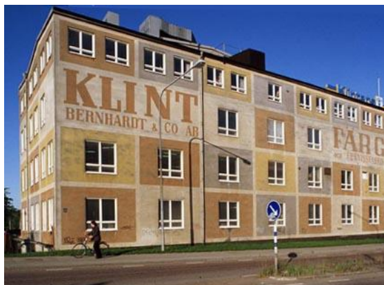
Färgfabriken "Klintens" 1950-talsfasad mot Värmdövägen
