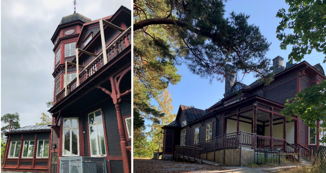
Figur 3 & 4. Villa Gadelius norra fasad (t.v.) samt västra fasad (t.h). Foto: Nacka kommun, 2020
