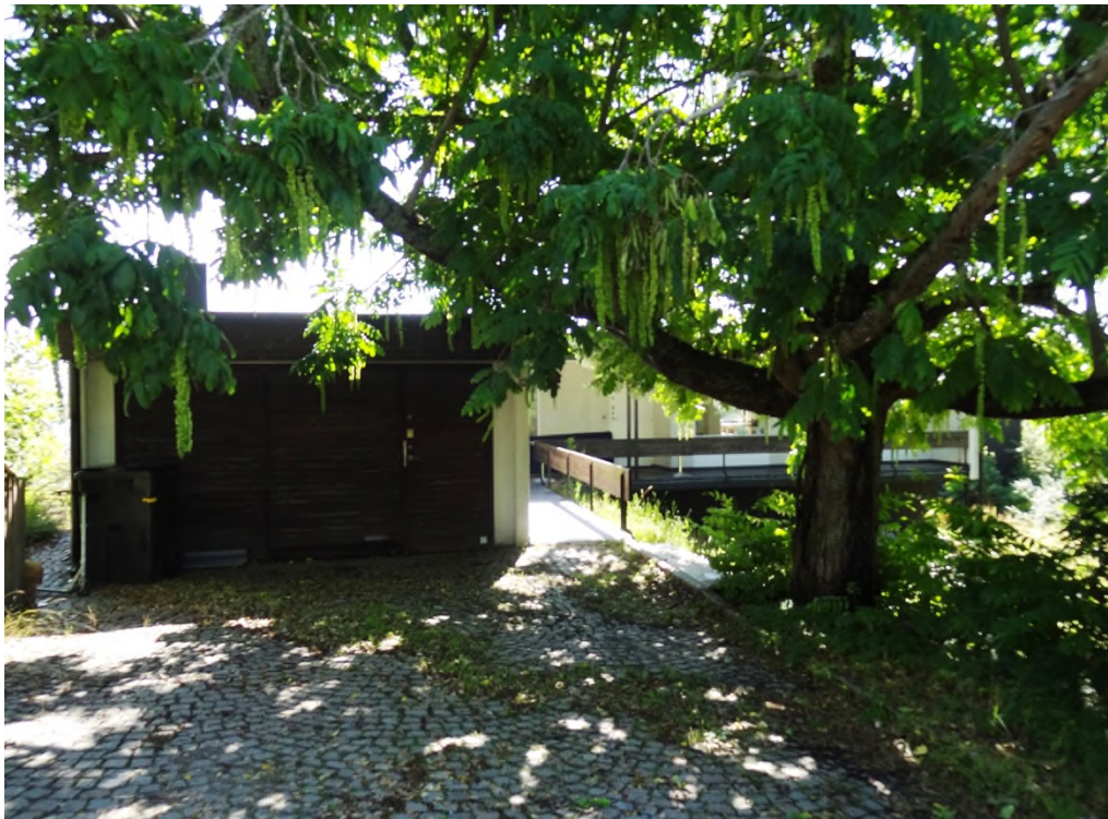
Igelboda 22:11, garaget vid entrén från gatan.
