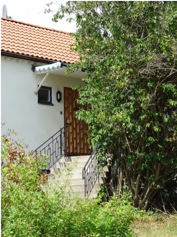
Entrén har många tidstypiska detaljer.
