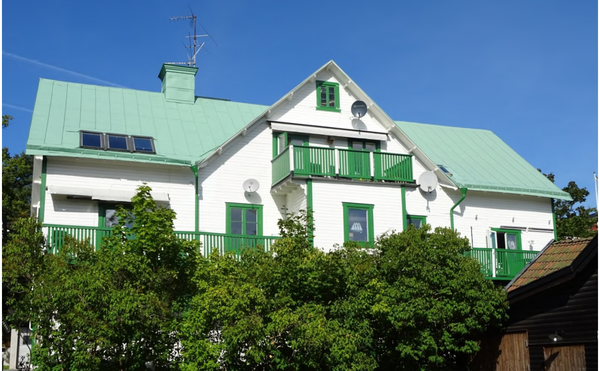
Igelboda 45:5 sett från söder.
