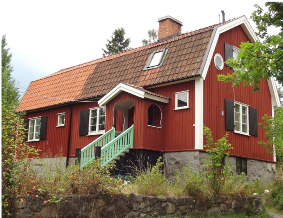
Igelboda 18:13 med utbyggnad mot öst, sett från Vasavägen.
