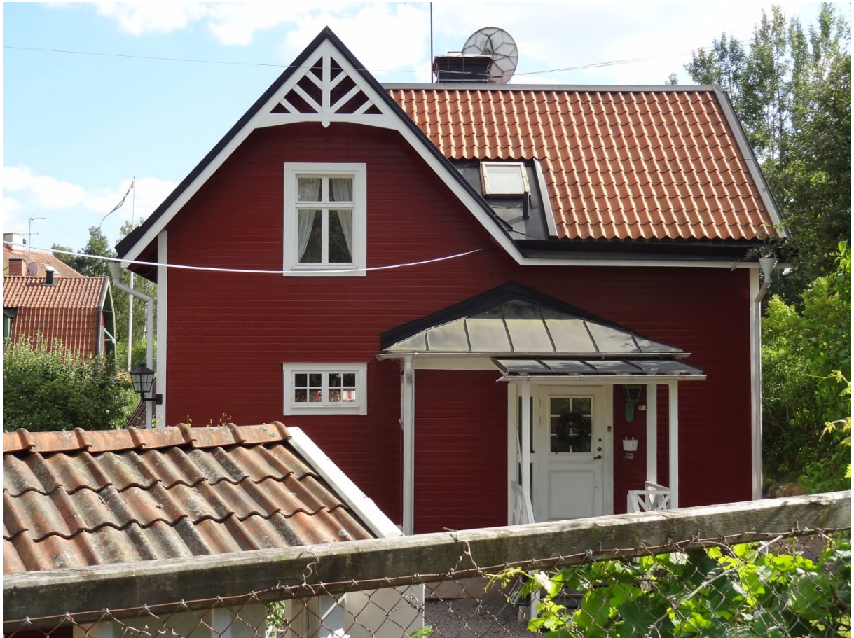
Igelboda 12:8 sett från norr.
