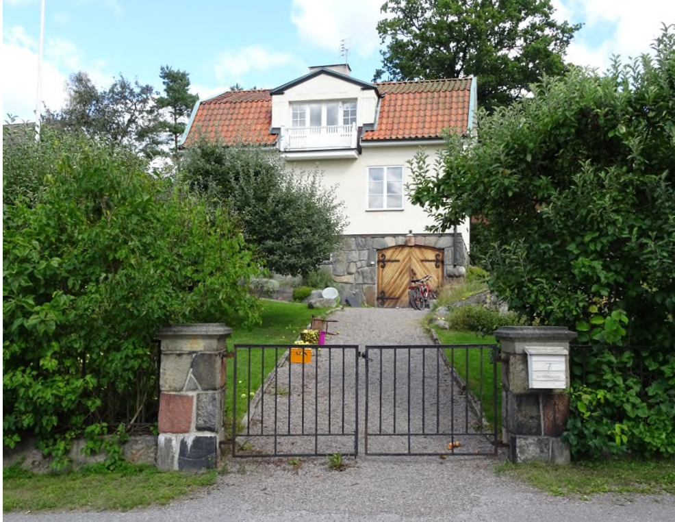
Igelboda 35:2 sett från Valhallavägen.
