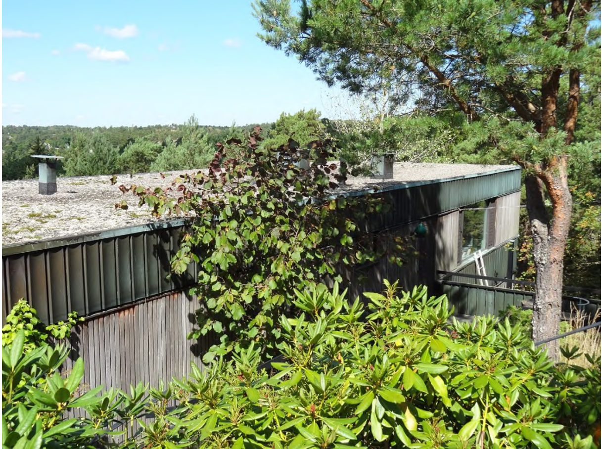
Igelboda 13:3. Byggnaden präglas av sin terränganpassning och utformning som suddar ut gränserna mellan ute och inne. Foto från Idunvägen.
