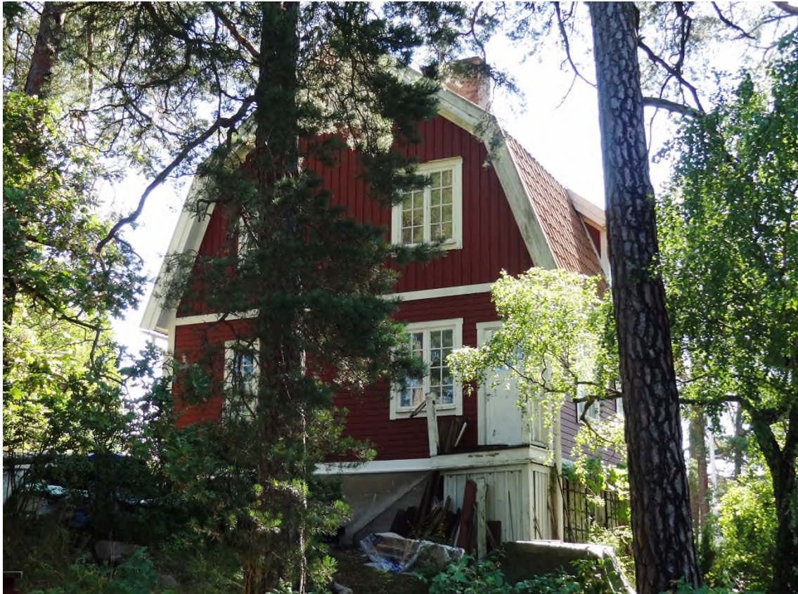
Igelboda 22:7 nordvästra gaveln sedd från Branta stigen.
