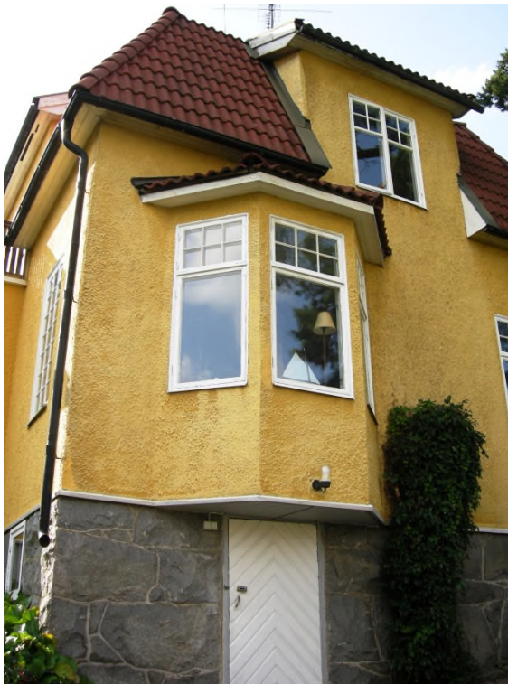
Detalj av fasaden med burspråket.
