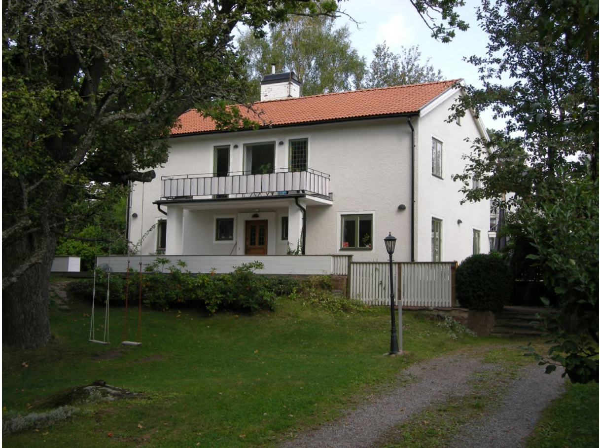
Igelboda 35:3 sett från Valhallavägen.
