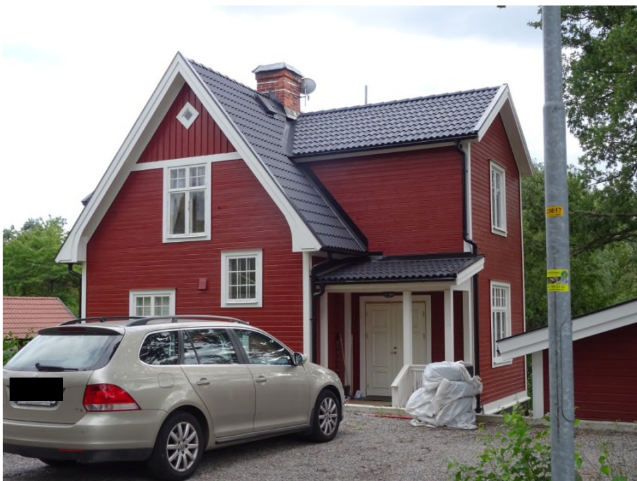
Igelboda 32:6 sett från Sleipnervägen i nordväst. Tillbyggnad och ny entré.
