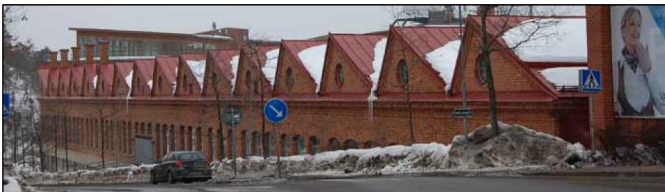
Befintlig hallbyggnad mot väster sett från Augustendalsvägen, idag innehållandes mässverksamhet.
