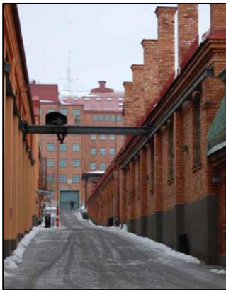
Delar av bevarad industribebyggelse.
