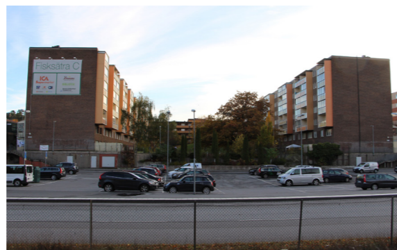
Stora parkeringsytor och körbanor påverkar intrycket av platsen.
