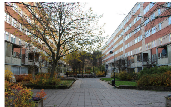
Entrésidan av bostadshusen ligger på garagebjälklag men har träd och växter.
