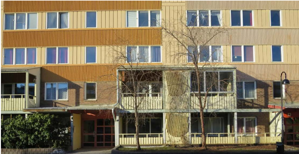
Byggnaderna har en-, två- och trelufts-fönster
