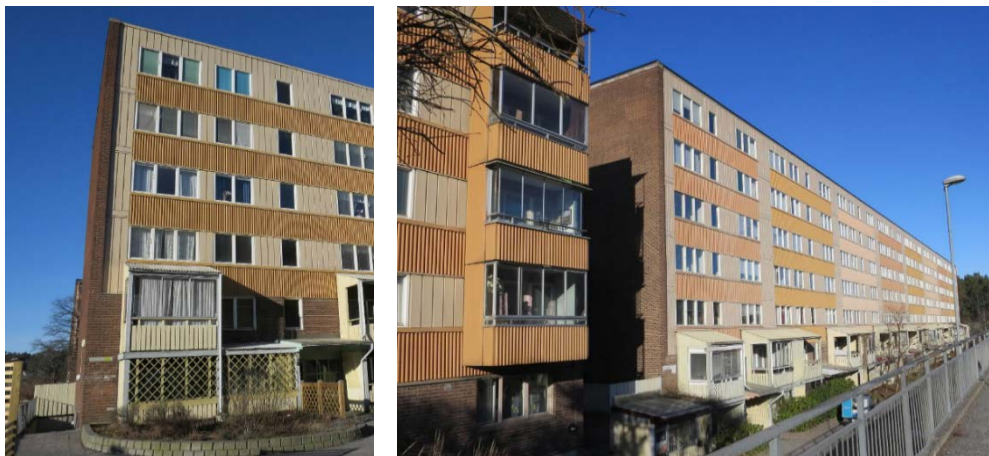
Byggnadsvolymerna med sitt horisontella uttryck, tegelgavlar, variation i material och kulör.
