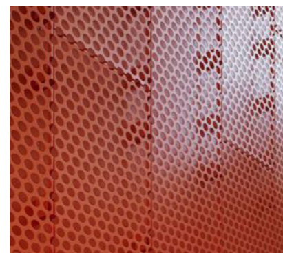
Fönsterbröstningsdetaljer i perforerad plåt
