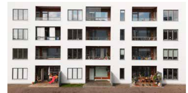
Referens fönsterband och indragna balkonger i avvikande material / kulör. Barkarby hage.
