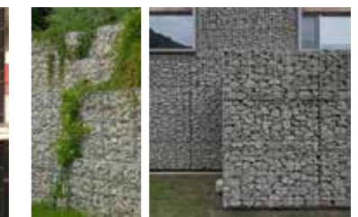
Referens stödmurar / fasadbeklädnad i gabion.
