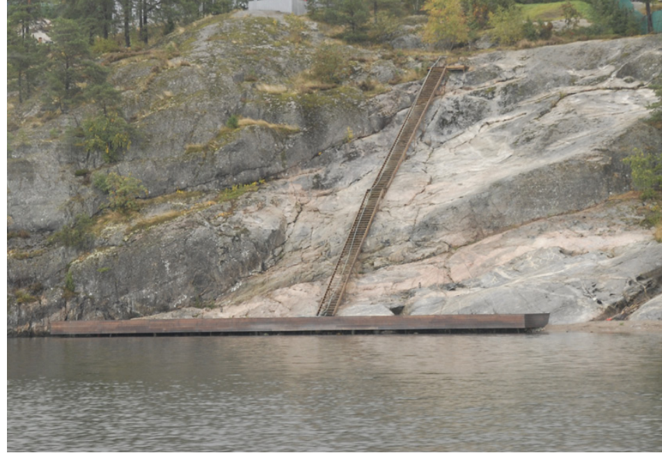
Ett exempel på hur en strandfastighet ianspråkats med brygga, trappa, staket och borttagande av vegetation.
